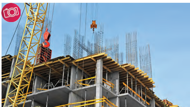
Fig. 15. Suprastructura unei construcții
